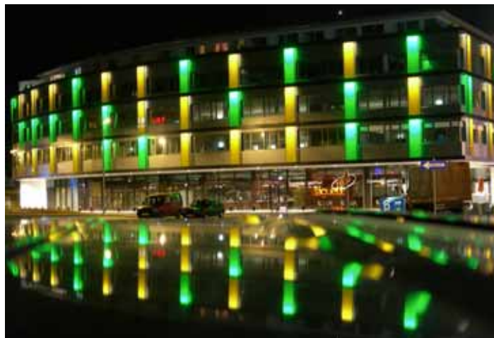
Die Projektabwicklung des Menardi-Centers erfolgte durch die Bürogemeinschaft Stimpfl/Stockner Baumanagement.
